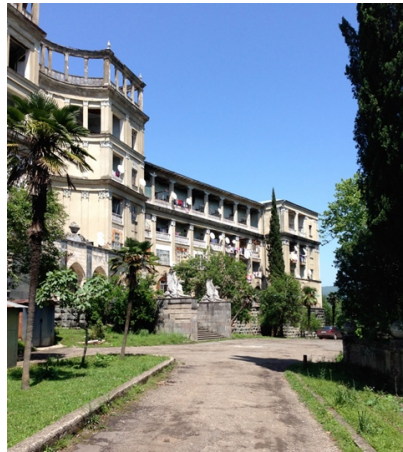
Eines der ehemaligen Sanatorien von Tskaltubo, Foto: Marcel Bleuler
